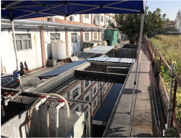
图 4-3 废水处理设施
