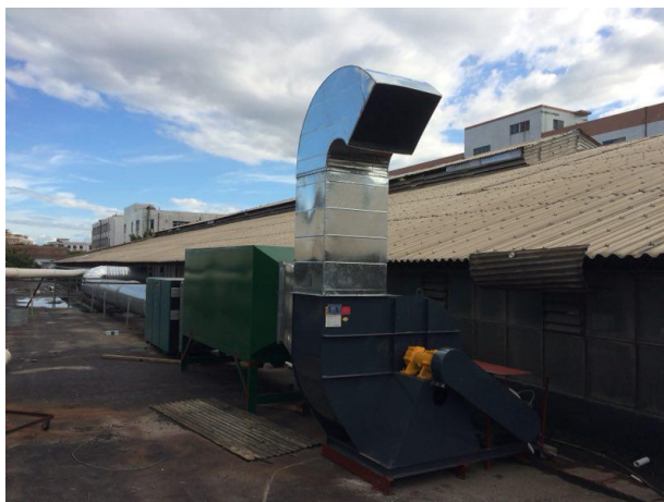
图 4-6 废气处理设施
